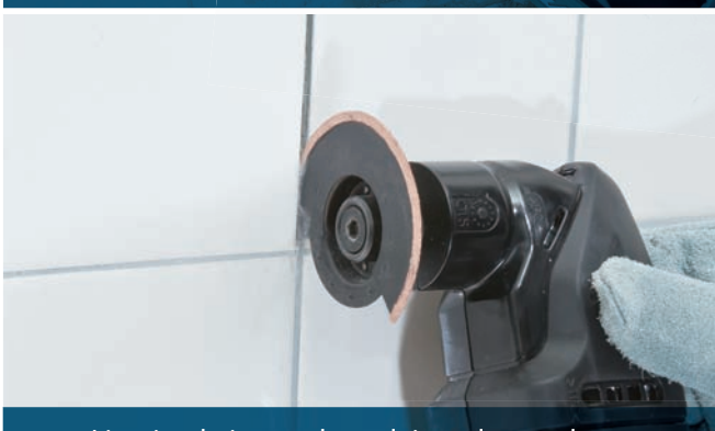
Limpiando juntas de azulejo en la pared
